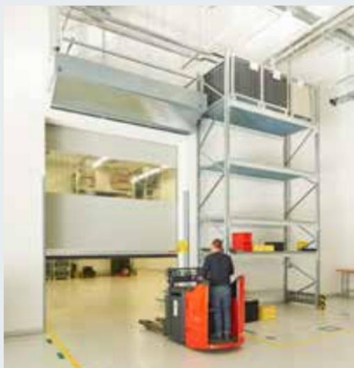
Скоростные ворота Hörmann используются в качестве внутренних и наружных ограждений для оптимизации транспортных потоков, улучшения микроклимата в помещении и сокращения энергозатрат.
